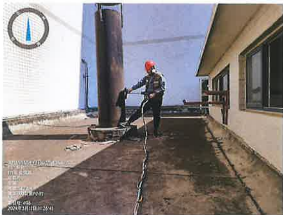
3#锅炉烟囱（DA003）
