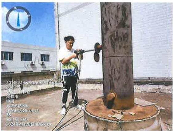
2#锅炉烟囱（DA004）
