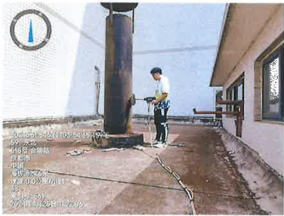
1#锅炉烟囱（DA003）
