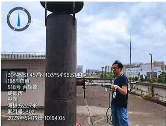
2#锅炉烟囱（DA004）
