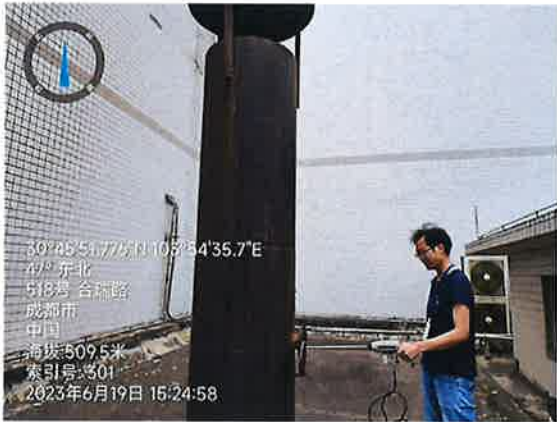
1#锅炉烟囱（DA003）
