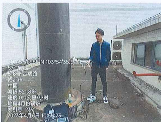
1#锅炉烟囱 (DA003)
