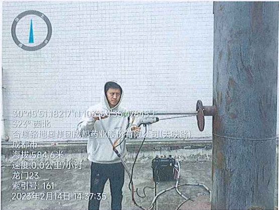
2#锅炉烟囱 (DA004)
