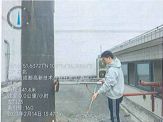
1#锅炉烟囱 (DA003)
