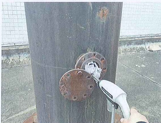
2#锅炉烟囱 (DA004)
