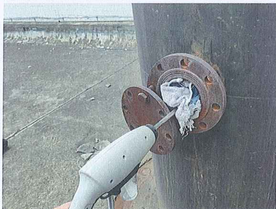
1#锅炉烟囱 (DA003)
