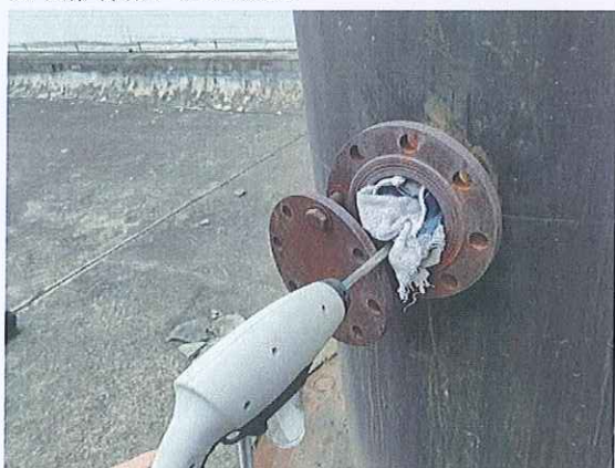
1#锅炉烟囱 (DA003)
