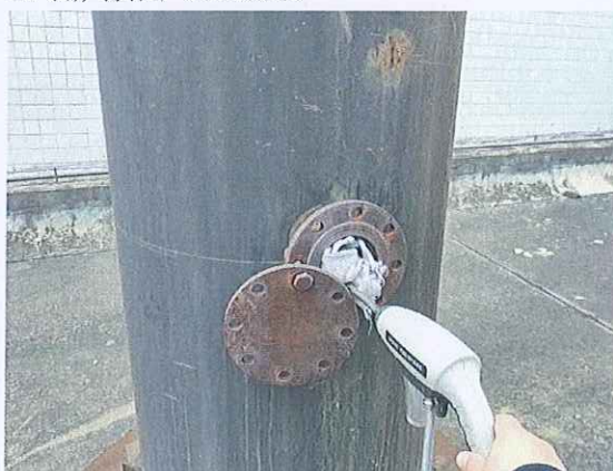
2#锅炉烟囱 (DA004)
